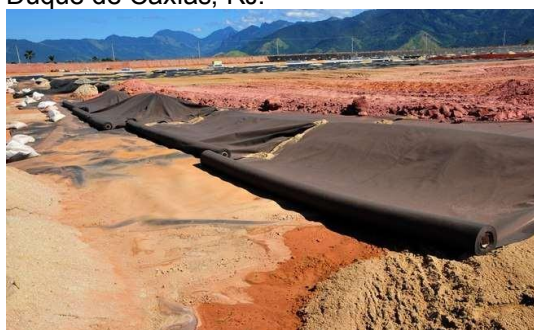
Figura 4 - Mantas de polietileno de alta densidade no Lixão de Gramacho, Duque de Caxias, RJ.
