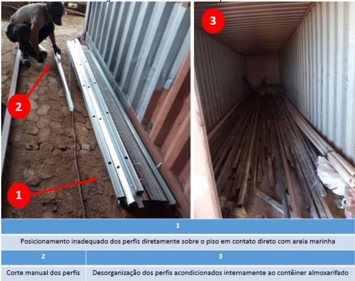
Figura 5 - Acondicionamento dos perfilados.
