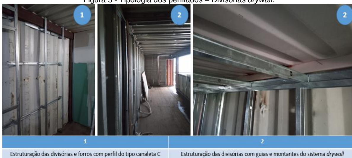
Figura 3 - Tipologia dos perfilados – Divisórias drywall .
