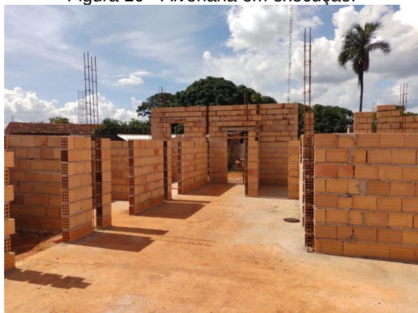
Figura 10 - Alvenaria em execução.
