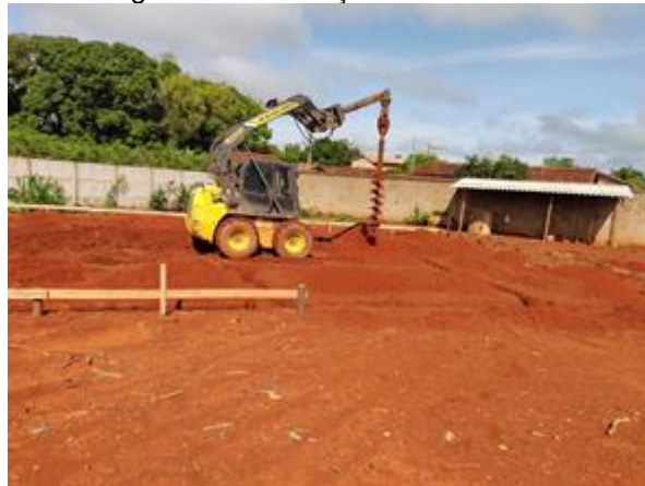
Figura 5 - Escavação das estacas.
