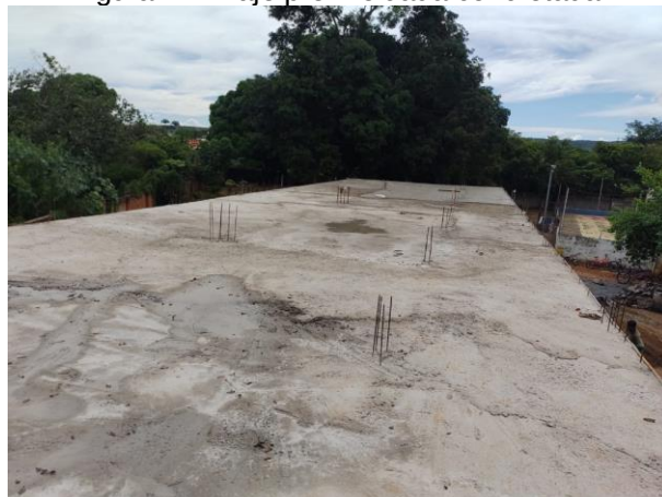
Figura 14 - Laje pré-moldada concretada.
