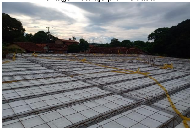
Figura 13 - Vista superior do processo de montagem da laje pré-moldada.
