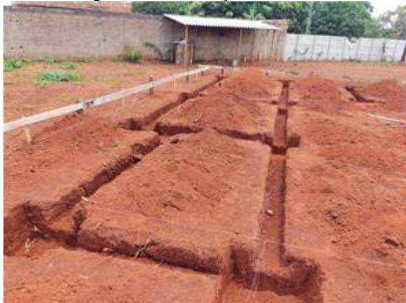
Figura 4 - Escavações manuais.
