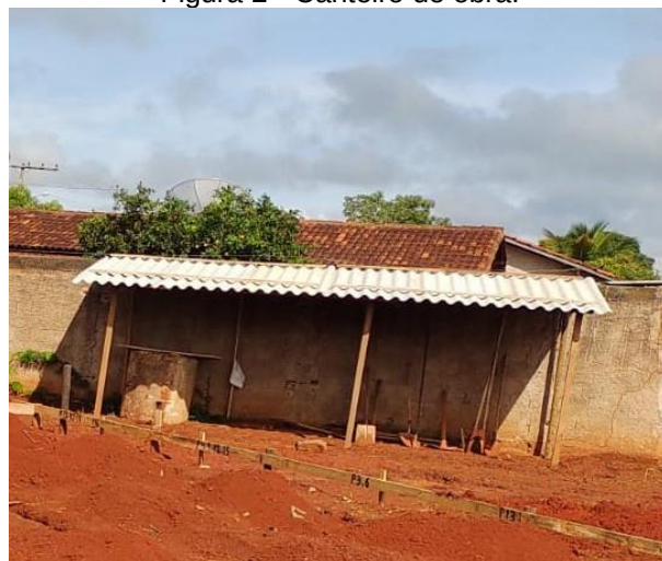
Figura 2 - Canteiro de obra.
