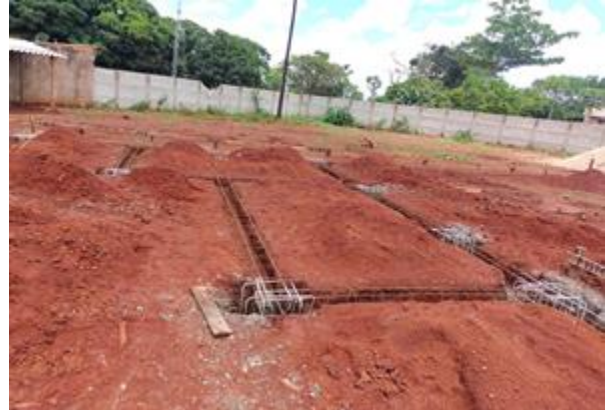
Figura 6 - Armaduras da fundação.
