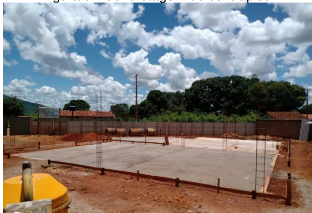
Figura 9 - Concretagem do contrapiso.
