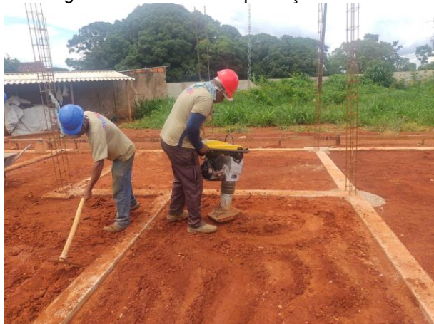
Figura 8 - Aterro e compactação do solo.
