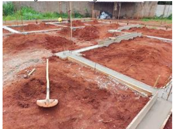
Figura 7 - Concretagem dos blocos.
