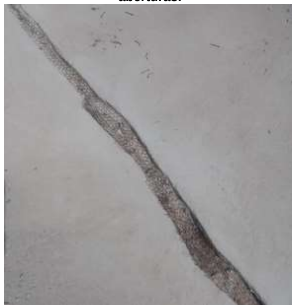
Figura 11 – Fixação das telas metálicas nas aberturas.
