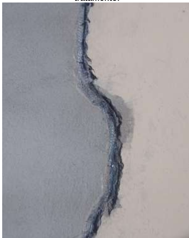
Figura 14 – Patologia da Figura 5 em fase de tratamento.
