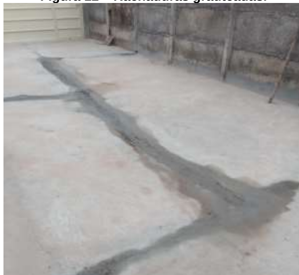
Figura 12 – Rachaduras grauteadas.
