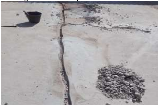
Figura 10 – Remoção das rachaduras.
