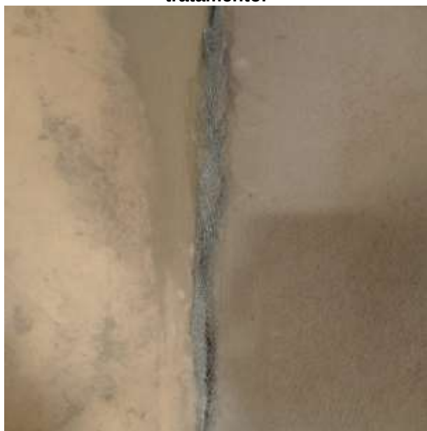
Figura 16 – Patologia da Figura 6 em fase de tratamento.
