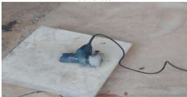
Figura 9 – Serra mármore usada para cortar o concreto.
