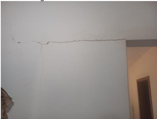
Figura 10 - Trinca Horizontal.
