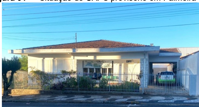
Figura 01 — Situação do CAPS provisório em Palmeira PR.
