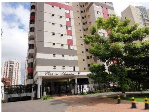
Figura 2: Vista do Condomínio Portal das Andorinhas, Fachada Principal. Fonte: acervo do autor.
