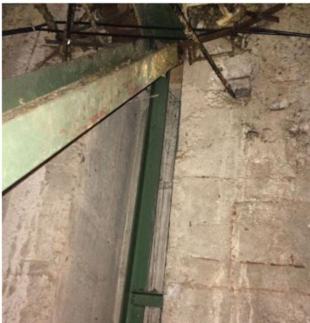
**Figura 9:** Detalhe do apoio da treliça metálica *in loco*.
