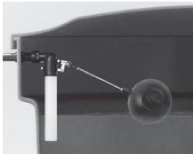
**Figura 3.** Boia mecânica instalada em reservatório.
