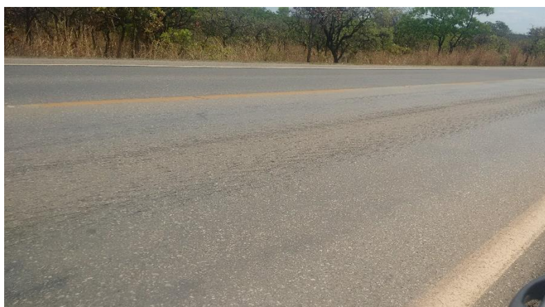
Figura 1 – Trilha de rodas no pavimento
