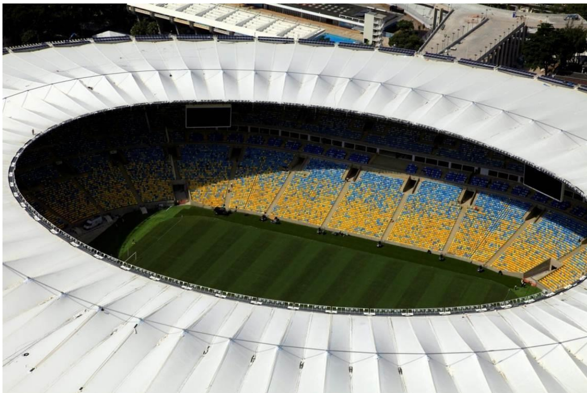
Figura 2 – Cobertura do estádio após a revitalização.
