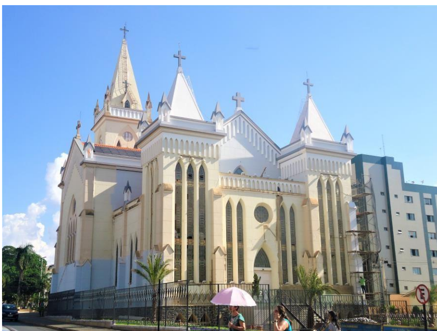
Figura 6 – Fachada após da retirada de palmeiras.
