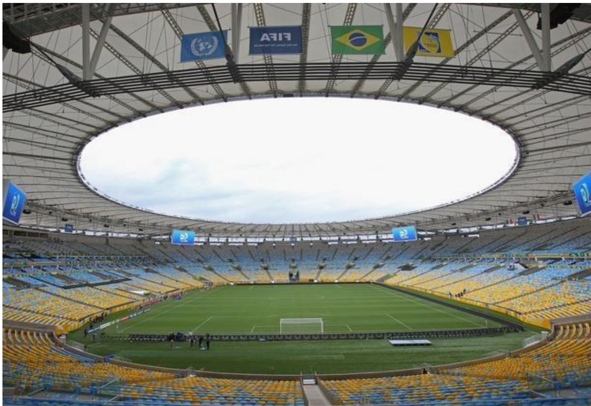
Figura 4 – Interior do estádio após a revitalização.
