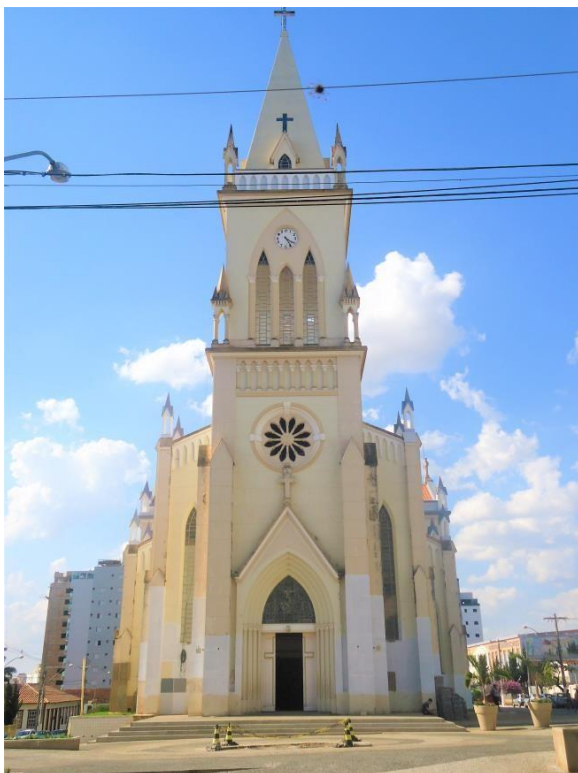
Figura 10 – Fachada principal da catedral durante a revitalização.
