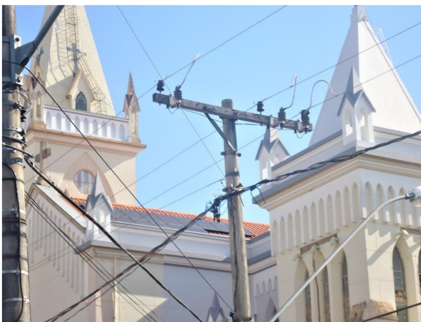
Figura 8 – Instalação das placas fotovoltaicas.
