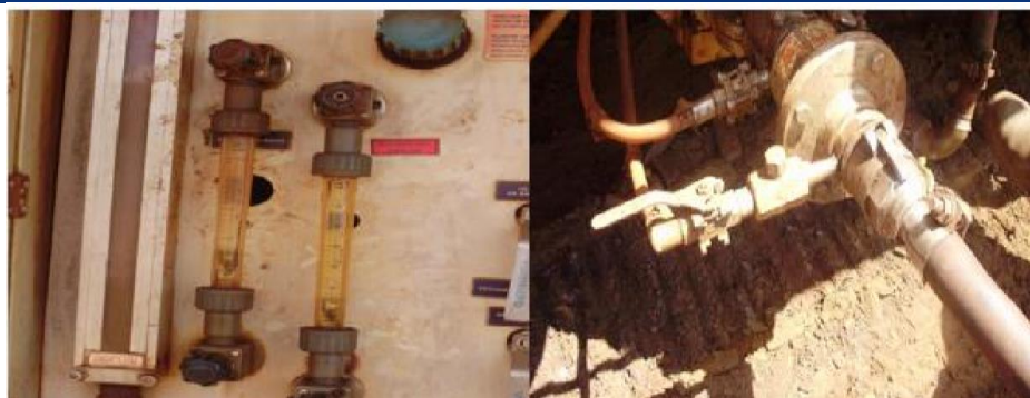
Figura 8: Bomba por onde adiciona-se o explosivo à perfuração. Fonte: Orica (2016)
