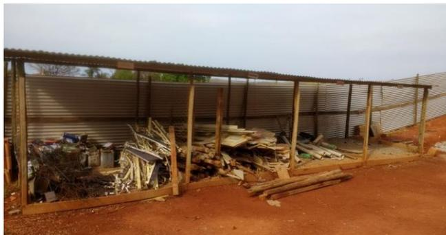
Figura 3 -Armazenamento de resíduos proveniente da obra
