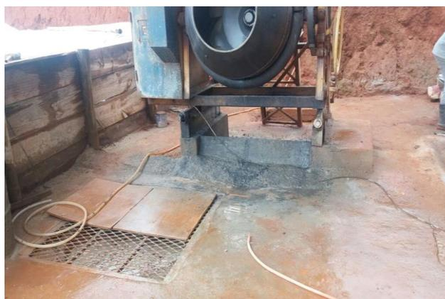
Figura 4 - Decantador de água utilizado na betoneira.
