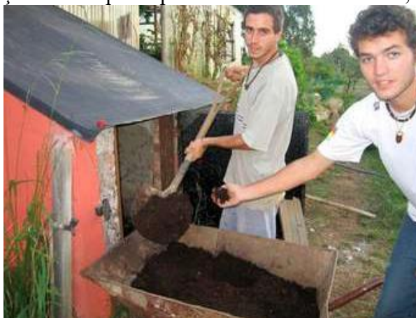
FIGURA 26: Remoção do composto pronto de dentro da câmara, depois de seis meses
