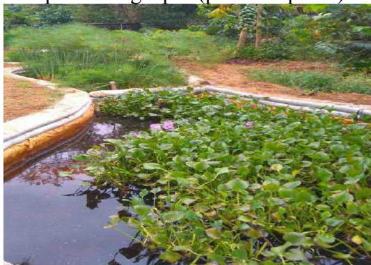
FIGURA 6: BSI semicoletivo em início de operação. Sistema de zonas de raízes flutuantes com papiros (ao fundo) e tanque com aguapés (primeiro plano) em pousada de Ubatuba-SP
