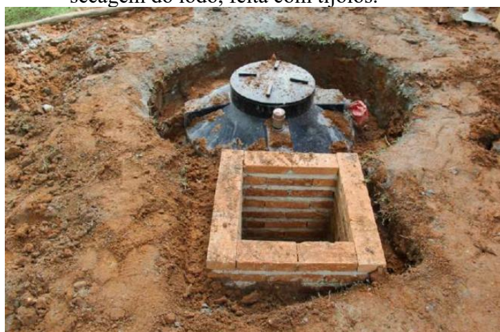
FIGURA 9: Vista geral de RAFA comercial, instalado ao lado da caixa para retirada e secagem do lodo, feita com tijolos.
