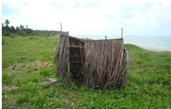
FIGURA 14: Fossa seca construída com folhas de coqueiro
