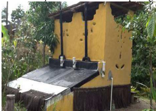
FIGURA 17: Banheiro seco construído em duplicidade em Itacaré, BA. A foto mostra a tubulação de ventilação e a câmara de compostagem
