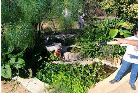
FIGURA 3: BSI unifamiliar no Espaço Almagestum, Pedra Bela-SP. O filtro anaeróbio e zona de raízes foram construídos sobre o biodigestor. No centro, o encanamento para saída do biogás.
