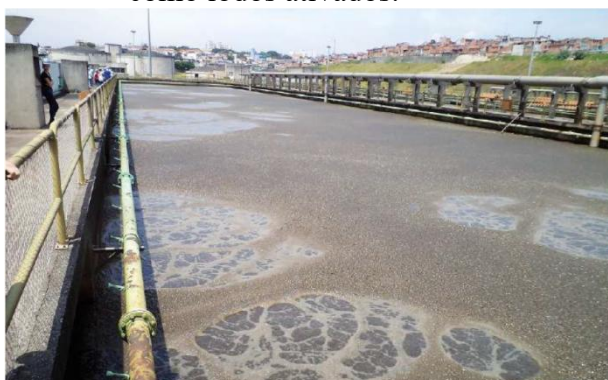
FIGURA 10: Processo de tratamento secundário de esgoto, com tecnologia conhecida como lodos ativados.
