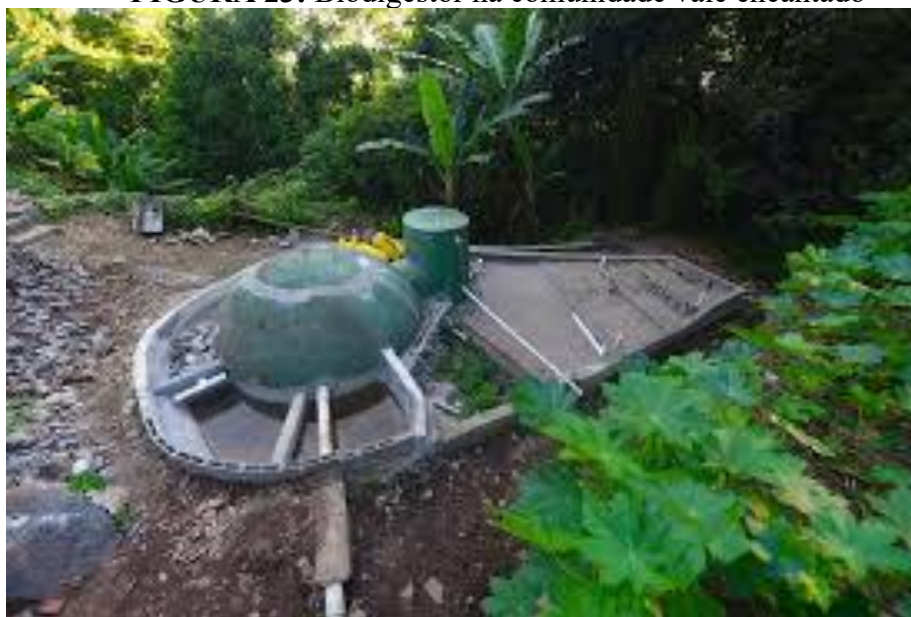
FIGURA 23: Biodigestor na comunidade vale encantado
